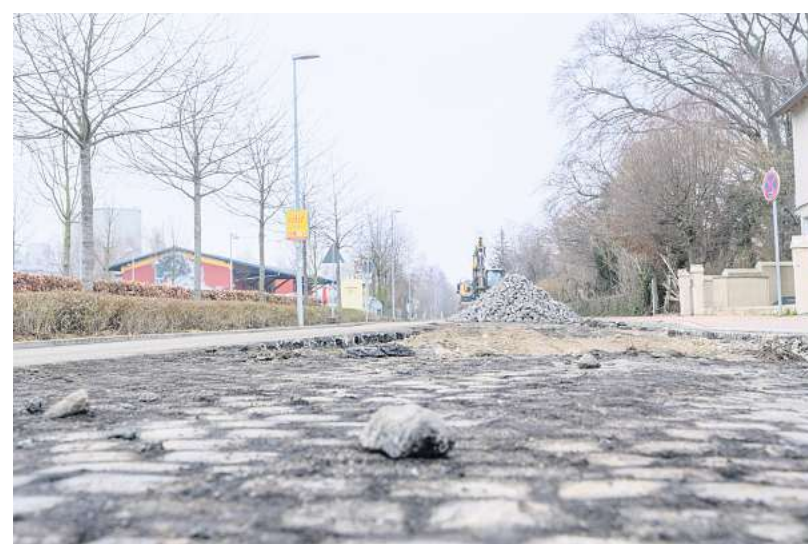
Die Bauarbeiten auf der L 410 zwischen Nordstemmen und Rössing gehen voran.
